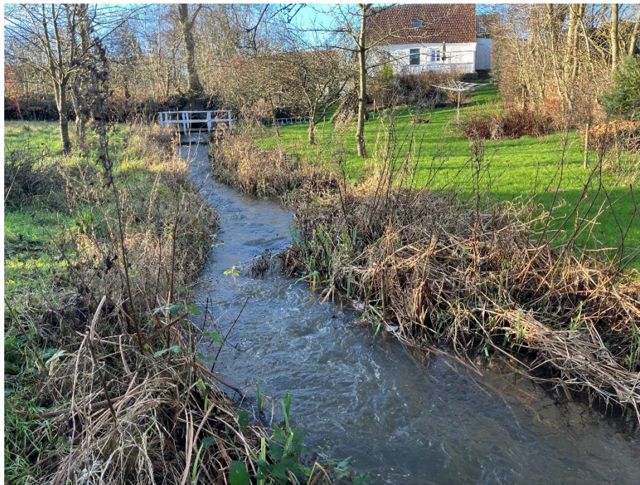
Figur 18: Strækning umiddelbart nedstrøms AAL-1199 i parcelhushaver
