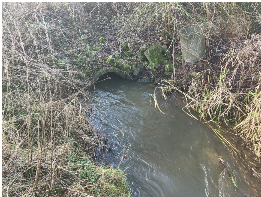
Figur 14: Spærring AAL-2026 set på udløbssiden.
