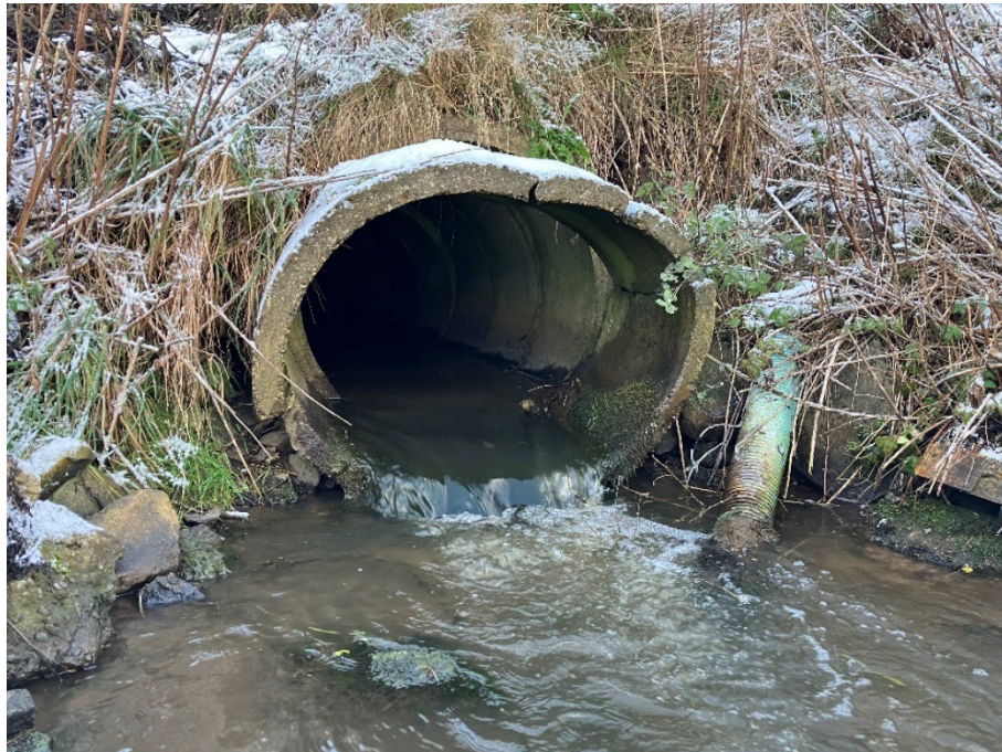
Figur 10: Udløbsside af spærring AAL-8139.
