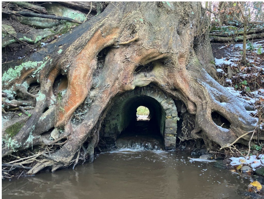
Figur 17: Udløbsside på spærring AAL-1199, Rævbjergvej
