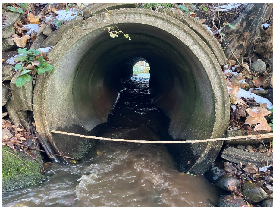
Figur 16: Indløbsside på spærring AAL-1199
