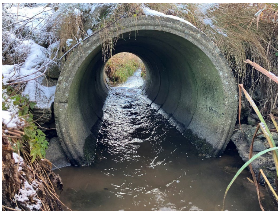
Figur 12: Spærring AAL-4448 set i opstrøms retning.
