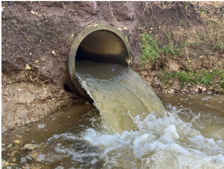
Figur 7: Udspring af vandløb fra privat rørlagt vandløb set i opstrøms retning.
